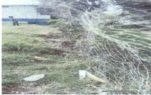
Foto 1: Ingreso al Establecimiento donde el muro esta construido con alambre y costales de tierra.
