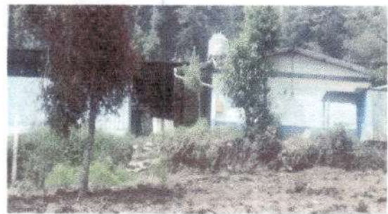
Foto 4: Vista de frente donde se necesita construir el muro perimetral.
