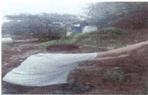
Foto 3: 37 metros lineales de muro para ser construido.
